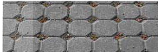
ריצוף מחלחל, תחת הריצוף מוצע לבצע אוגר למים ממולא חצץ ועטוף ביריעה גיאוטכנית.
