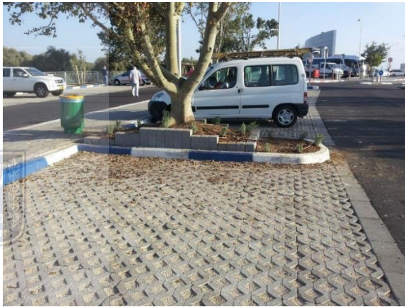
חנייה מריצוף חדיר בכביש 6. תחת הריצוף מומלץ אוגר למים ממולא חצץ ועטוף ביריעה גיאואסינטטית
